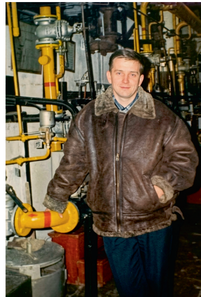
1997 год. Котельная Ковалевская ул., д. 14
